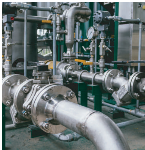
Réparation de pompe hydraulique Hydraulic pump repair
